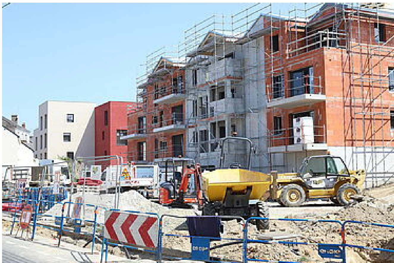
Travaux en cours
